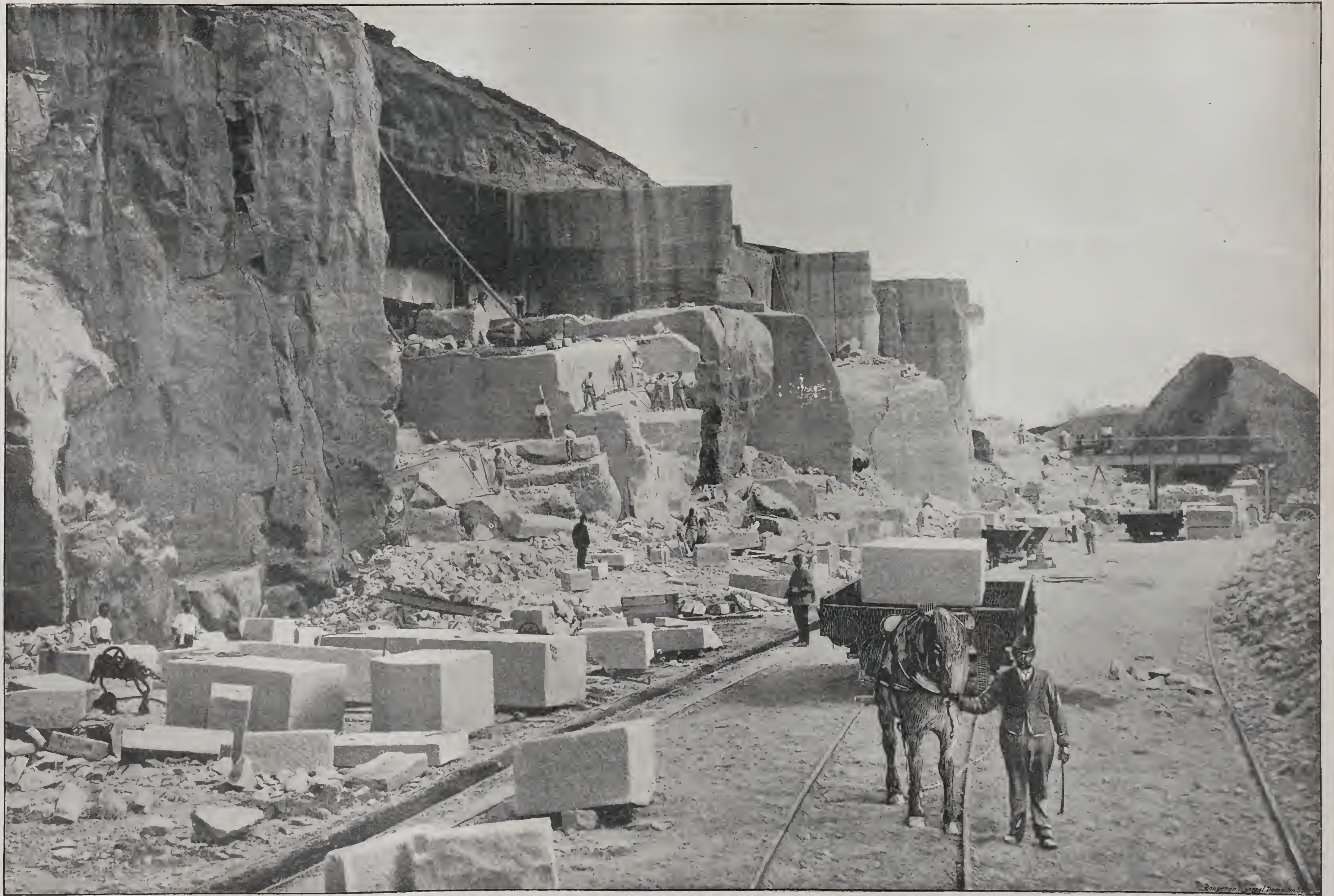
LES MATÉRIAUX DE L'EXPOSITION. — Exploitation de la pierre de taille, dans les carrières de Lérrouville.
